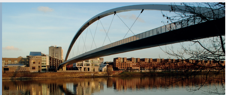
Die Hoge Brug Brücke in Maastricht The Hoge Brug Bridge in Maastricht
